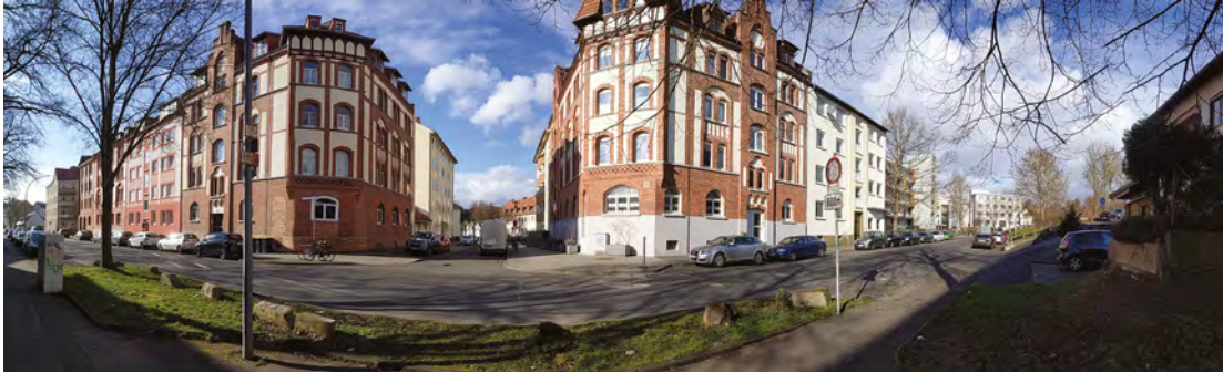
Abbildung 9.4: Bebaute Umgebung der Quellhofstraße, Kassel
