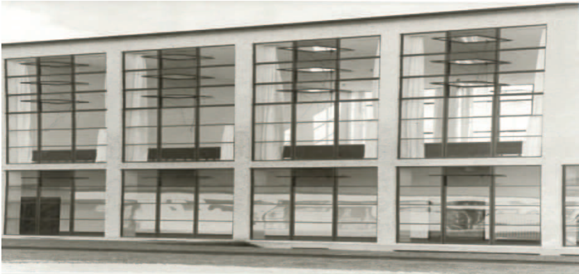
Außenansicht des Gebäudes vom Innenhof, 1930 (Quelle: Oellers / Böhmer 1997, Tafel 20)
