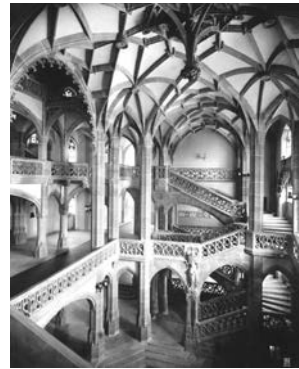
Bild 3.61: Amtsgericht Wedding, erbaut 1901-1906, Architekten Rudolf Mönlich und Paul Thoemer, Treppenhaus, Foto: 1906
