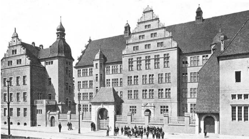
Bild 3.13: Gemeindedoppelschule Glogauer Straße, erbaut 1901, Architekt Ludwig Hoffmann, Foto: 1901
