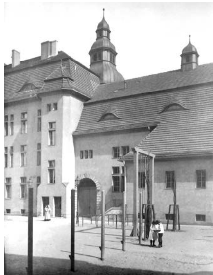
Bild 3.15: Gemeindedoppelschule Pappelallee, erbaut 1898, Architekt Ludwig Hoffmann, Foto 1898
