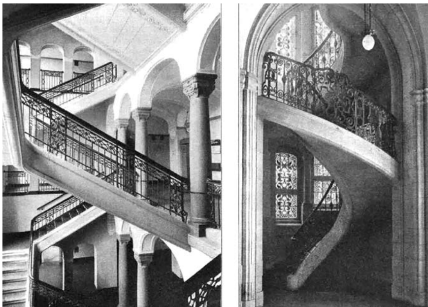
Bilder 3.57, 3.58: Das Neue Kriminalgericht Berlin-Moabit, erbaut 1906-1908, Architekten Carl Vohl und Rudolf Mönnich, Treppenhäuser, Fotos 1908
