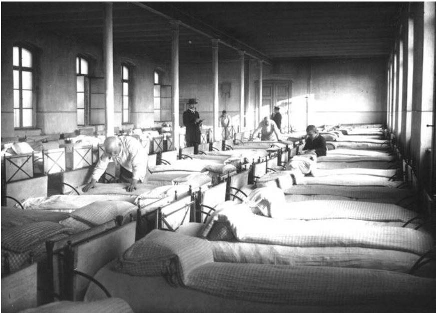
Bild 3.40: Städtisches Arbeitshaus Rummelsburg, Schlafsaal für Männer, erbaut 1877-79, Architekt Hermann Blankenstein, Fotografie 1925, © AKG-Images
