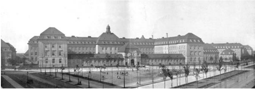
Bild 3.34: Rudolf-Virchow-Krankenhaus Hauptgebäude am Augustenburger Platz, erbaut 1899-1907, Architekt: Ludwig Hoffmann, Foto: 1907
