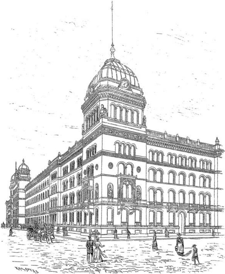
Bild 3.50: Polizei-Präsidium am Alexanderplatz, erbaut 1886-90, Blick vom Alexanderplatz, Architekt Hermann Blankenstein, Druck 1896
