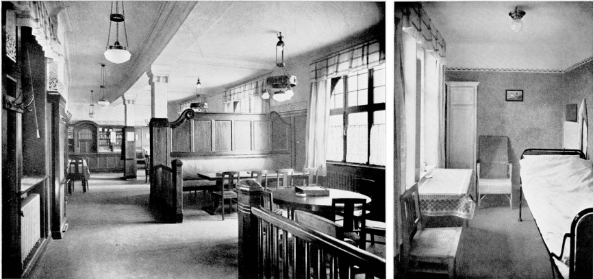
Abb. 1: Der Gemeinschaftsraum (li.) und ein Zimmer (re.) im Ledigenheim an der Rehhoffstraße in Hamburg.
