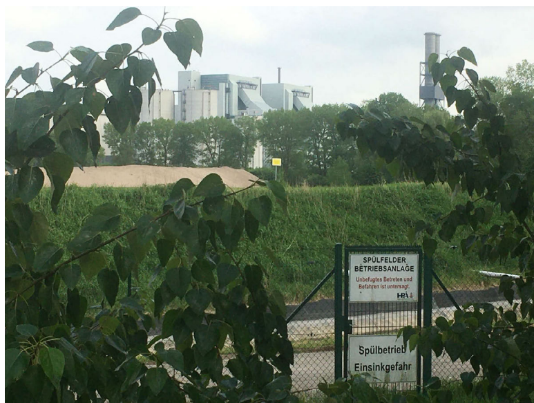
Abb. 2: Spülfelder in Moorburg (vorne) und Kraftwerk Moorburg (hinten)
