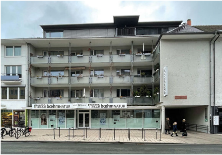
Abb. 32 Aufstockung um ein Staffelgeschoss in der Grafenstraße 27
