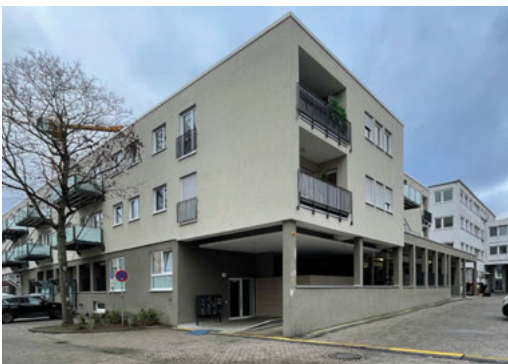
Abb. 33 Aufstockung auf einer Garage um zwei Wohn- geschosse in der Rheinstraße 49
