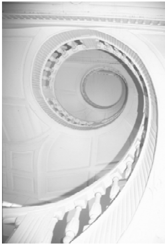
Blick in das unter dem Architekten Simon Louis du Ry um 1790 erbaute klassizistische Treppenhaus im Palais Bellevue in Kassel – Ausgang zur Dauerausstellung zu Leben und Werk der Brüder Grimm. (Foto: Bernhard Lauer, 2005)
