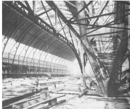
Abb. 21. Die Stahlkonstruktion im Inneren des Manufactures & Liberal Arts Building, aufgenommen während der Bauzeit, 1892.
