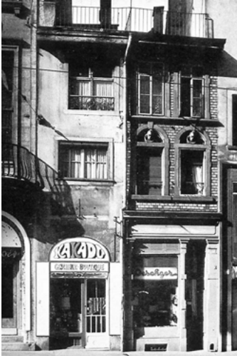
Basel, Marktgasse 18–20 vor und nach der Sanierung 1976
