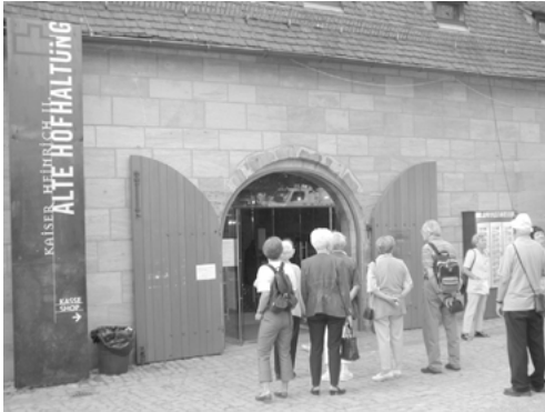
Abbildung 41: Orientierungshilfen in Form von großformatigen Stelen aus Cortenstahl an den Eingängen der verschiedenen Ausstellungsorte.
