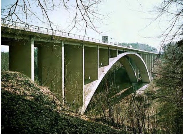
Abb. 92: Die Teufelstalbrücke Der Autobahn 4 in Thüringen, erbaut 1938, ist ein Ausnahme, da sie mit der Sichtbetonbauweise an die Moderne des Bauhauses erinnert und nicht wie üblich mit Naturstein heimatisch verblendet wurde; Jörg Blobelt, 1988, Wikimedia.
