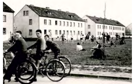
E 1405,0259 Hauptdurchgangslager Massen, ca. 1955. Landesstelle Unna-Massen / DOMiD-Archiv, Köln
