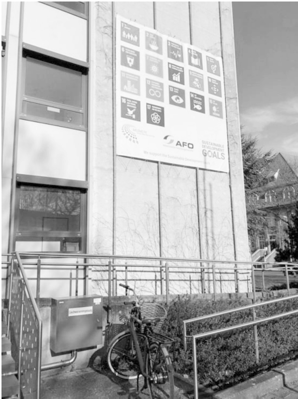
Abb. 4: Ein Bekenntnis zu den SDGs an der Fassade des Gebäudes der AFO
