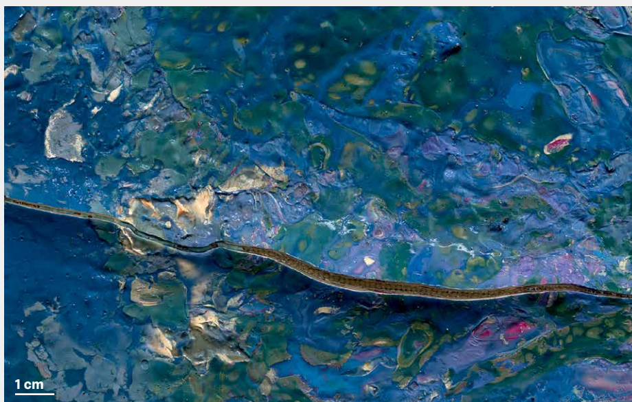
Abb. 6.15 Detail Landschaft IV, Rissbildung Zustand 2018. Das Verhalten der Farbschicht im Rissbereich ist schwer vorauszusagen. Die Grundierungsschicht ist elastisch wie auch die aufliegende Farbschicht. Sie ist in die Risse eingeflossen. Die Alkydharzschicht wird – in Abhängigkeit des Füllstoffgehaltes – hart und steif, wenn sie trocknet. Es ist anzunehmen, dass die Versteifung der Malschicht im Rissbereich zu einer Zunahme der Abhebungen führen wird.
