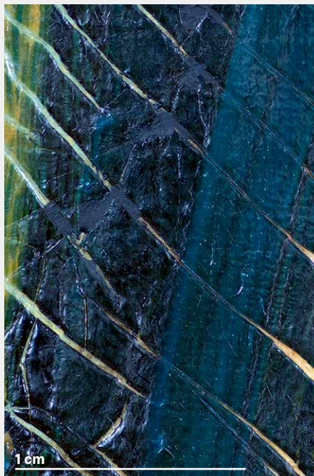
Abb. 1.11 Detail Risse, Mantel unten links. Sichtbar ist der Einfluss der lokalen Überarbeitung auf die Öffnung der Schwundrisse. In den überarbeiteten Bereichen sind die Risse weniger weit geöffnet.
