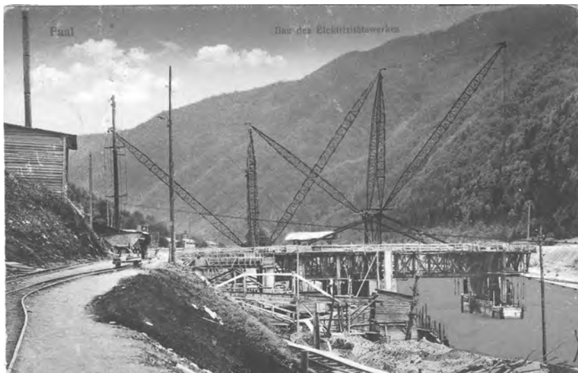
Abb. 5: Faal, Bau des Elektrizitätswerkes, Verlag Albin Sussitz, gelaufen 1916
