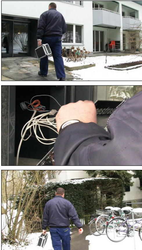
Abb. 1: Vor, während und nach der Klingelreparatur.
