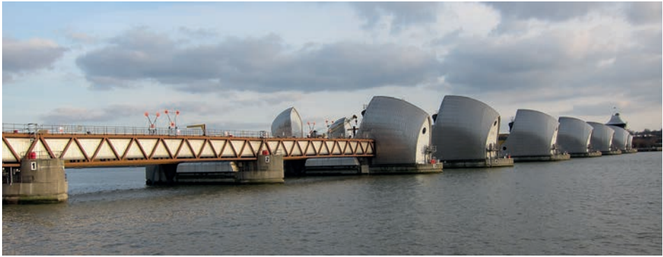
Abb. 3 1982 erbaute Flutbarriere in der Themse, nahe des Stadtteils Woolwich im östlichen London, mit einer Breite von 520 m. Zwischen neun riesigen, auf Betonfundamenten ruhenden, holzschuhförmigen Wellenbrechern sind gewaltige Drehtore aus Stahl montiert, die sich bei extremer Flut aufrichten und das Inland von der Meereseite des Flusses abriegeln, um landeinwärts dringenden Wassermassen ihre Hochwasserspitzen zu nehmen. (Foto: Paul Pichota/Wikipedia, CC BY-SA 2.0)
