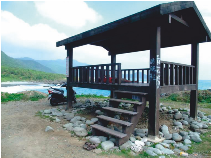
Abbildung 21: Moderne tagakal außerhalb des Dorfes Ivalino – Unterstand mit erhöhtem Boden ohne Wände.
