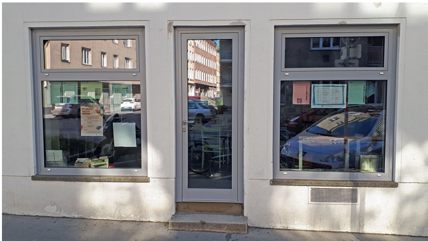
Foto 10: Fassade eines Quartiersnetzwerks (2019)
