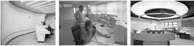
Abbildung 49: Leitwarte der Stadtwerke in Tübingen 1976, 2001 und heute.
