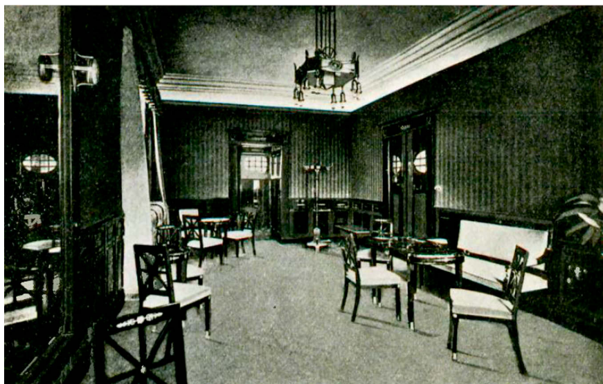
Abbildung 33: Damensalon im Hauptbahnhof Wiesbaden.
