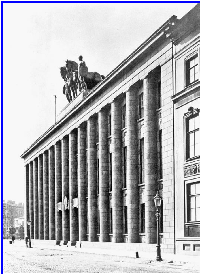
Abbildung 94: Die Fassade der Botschaft zum Isaaksplatz aus der Perspektive des Vorüberfahrenden: Beim sich nähern und entfernen lösen sich die Details auf in eine rhythmisch-glatte Pfeilerwand. Ganz anders die Frontalperspektive, mit ihrem Wechsel von Säulen und Fensterzwischenräumen, glattem und rustiziertem Mauerwerk. Abbildung aus: Der Profanbau 10 (1914), Nr. 12, S. 317. StBPK 4 Ny2825/7–1914,2.
