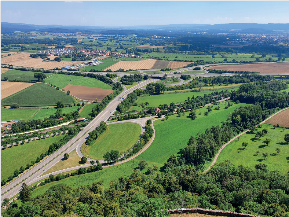
Abb. 1: Raumgreifende Wirkung von Straßen: Autobahnkreuz bei Singen am Hohentwiel an der A81 (Foto: Ulrich Walz)
