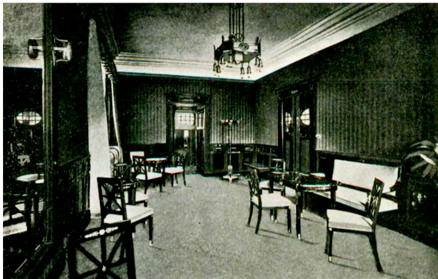
Abbildung 33: Damensalon im Hauptbahnhof Wiesbaden.
