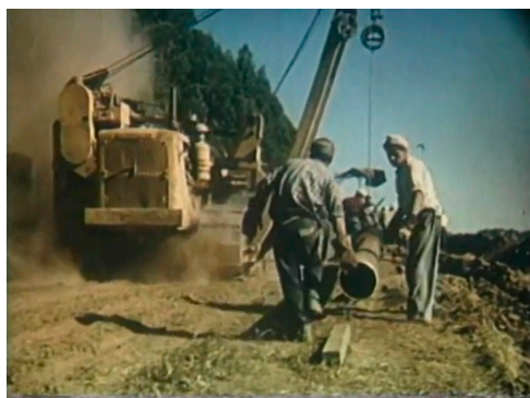
Obreros instalando un sistema de cañerías ( Energía gris , 1960)
