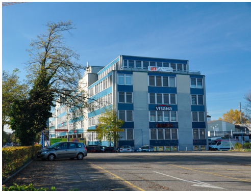
Abbildung 6: Albanische Moschee, Außenansicht, Zürich 2014 19 .
