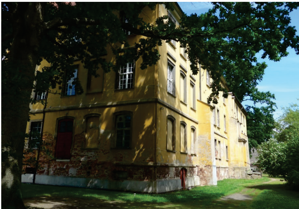
Abb. 33 Schloss Lieberose - vorübergehend ungenutztes Gebäude mit Park (Foto: Syrbe / IOER)
