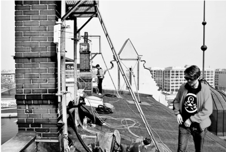
Abbildung 1: Freifunker*innen verlegen Kabel bei FluxFM
