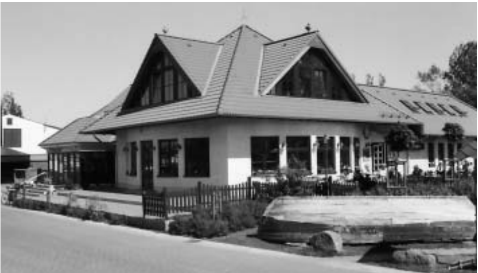
Abb. 10 Das 1997 errichtete Gebäude der FG »Greifswalder Bodden« in Wieck, 1999: Verwaltung, Fischverkaufsstelle und Restaurant unter einem Dach.
