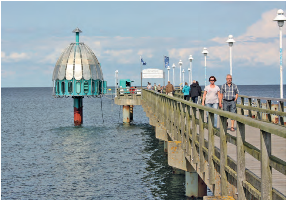
Abb. 16 Seebrücke von Zinnowitz/Usedom mit Tauchgondel.
