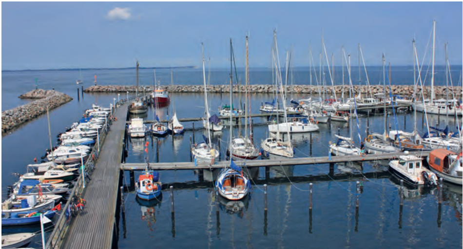
Abb. 14 Der im Jahr 2000 fertiggestellte Hafen von Glowe/Rügen, in dem auch Fischerboote Liegeplätze haben.
