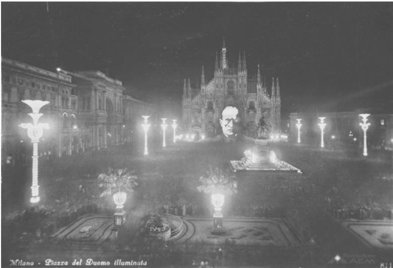
Source: AEM (Azienda Elettrica Municipale), Archivio Fotografico
