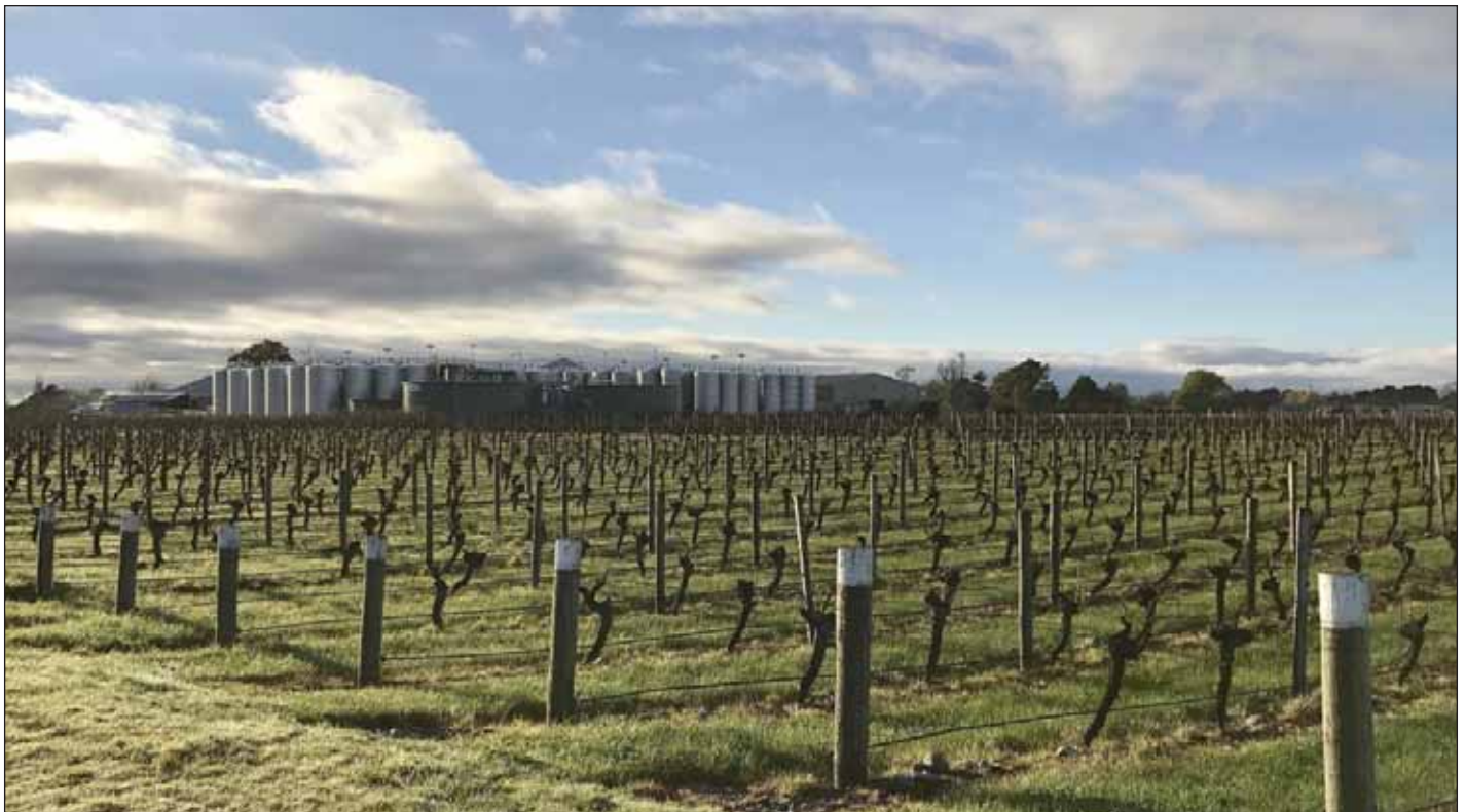
Foto 3: Kühltanks im Marlborough
