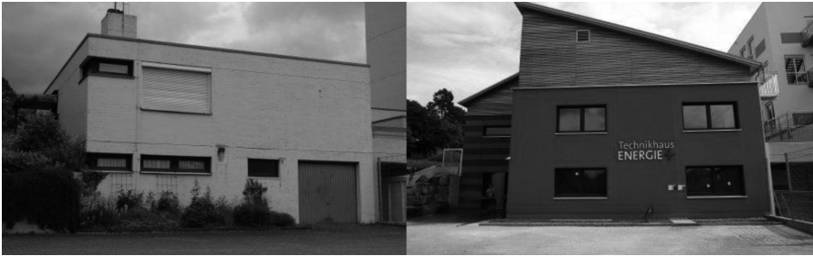
Abb. 1: Technikhaus Energie Plus – vorher und nachher
