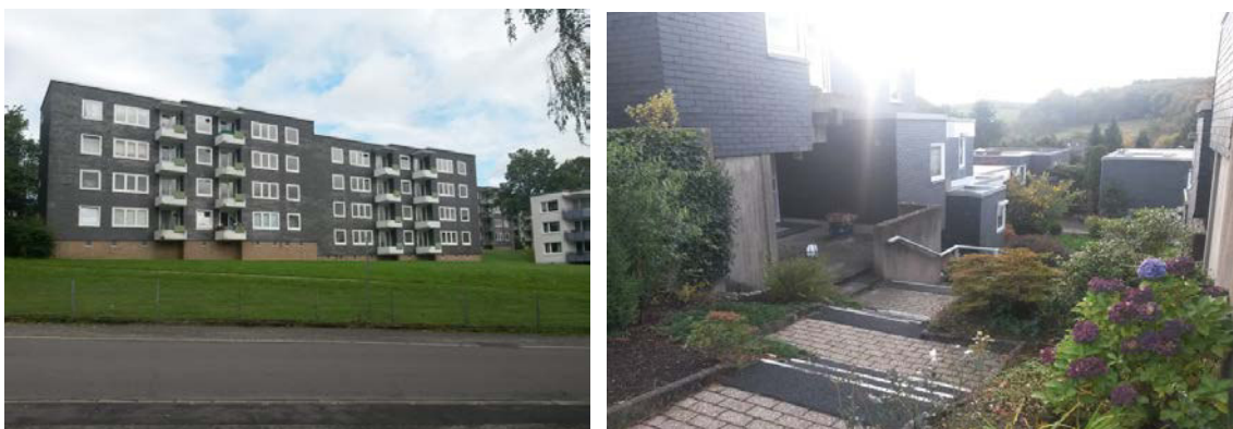
Abbildung 14: Geschosswohnungsbauten und Bungalows am Hasenberg
