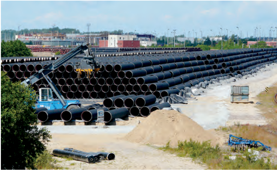
Abb. 1 Lager der Pipeline-Rohre in Mukran.
