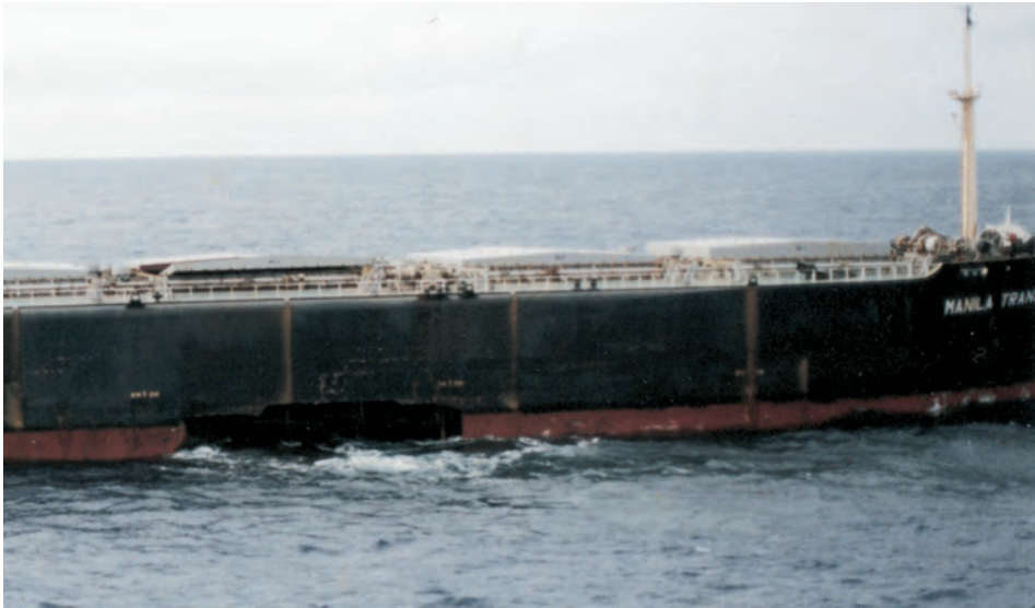
Abb. 3 Gut zu erkennen die Beschädigungen im Bereich der Luke 3, hier an Steuerbordseite.
