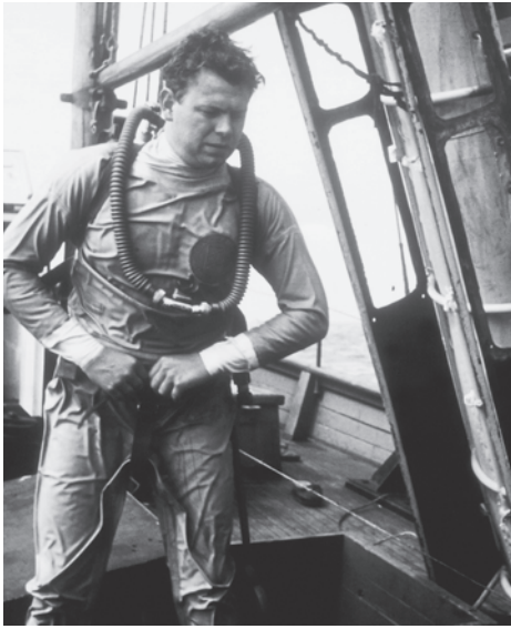
Abb. 13 Hermann Winkler als Forschungstaucher mit leichtem Presslufttauchgerät, 1958. Der zweiteilige Trockentauchanzug ist eine eigene Anfertigung. (Foto: Peter Weiss)
