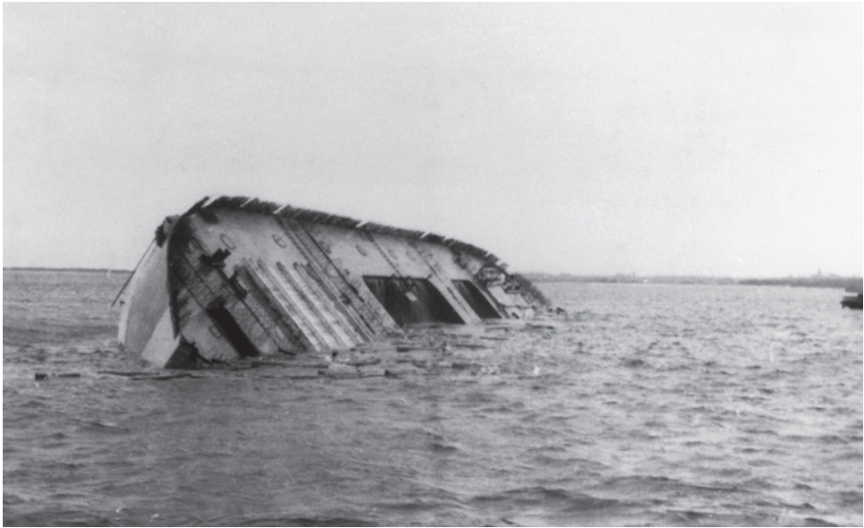
Abb. 22 Die kritische Phase des Drehvorgangs ist überstanden und die Gefahr des Volllaufs gebannt. Die Schalungen in Luke 1 und im Maschinenschacht haben dem Wasserdruck standgehalten. (Werksfoto Dyckerhoff & Widmann/Archiv DSM)
