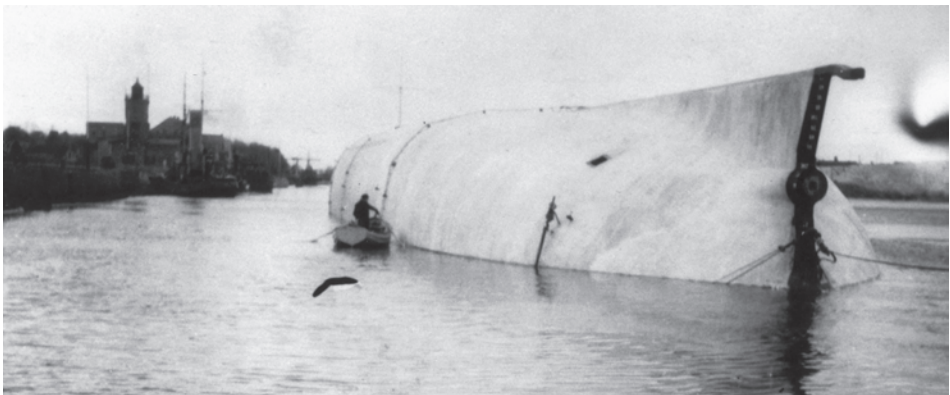
Abb. 19 Die ausgedockte Bau-Nr. 2 der Rügenwalder Werft wird zur Vorbereitung der Drehung auf See im Mai 1944 an die Ostmole verholt. Links im Hintergrund die Lotsenstation Rügenwaldermünde. (Werksfoto Dyckerhoff & Widmann/Archiv DSM)
