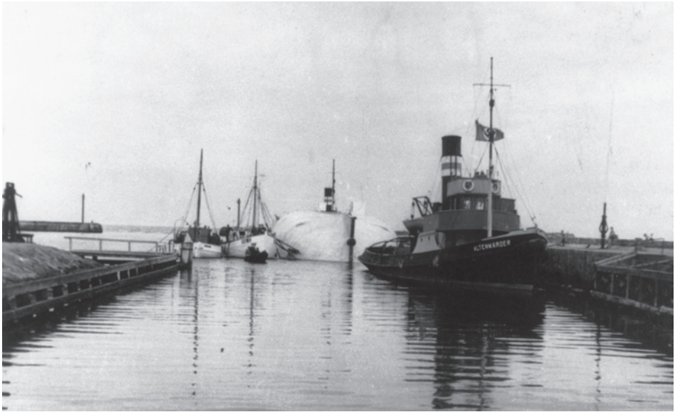
Abb. 20 Der Rumpf des noch kieloben schwimmenden Betonfrachters wird von einem Schlepper von der Rügenwalder Ostmole aus seewärts gezogen. An der Backbordseite sind zwei Rügenwalder Fischkutter als Träger für die Pumpen vertäut. Achterlich assistiert der Schlepper ALTENWERDER. (Werksfoto Dyckerhoff & Widmann/Archiv DSM)
