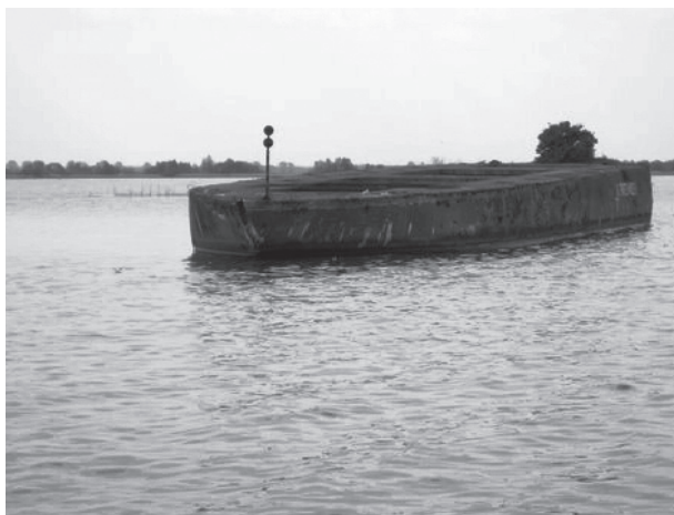
Abb. 17 Das Wrack des nie fertiggestellten Beton-Motortankschiffes ULRICH FINSTERWALDER liegt vermutlich seit seiner Abbergung aus dem Peenestrom durch ein polnisches Bergungsunternehmen 1970 im Dąbie-See bei Stettin. (Foto: Ole Wordolff, Kopenhagen, 2009)
