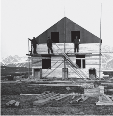
Abb. 1 Aufbau des Hauptgebäudes des Observatoriums vom 19. Juni bis 10. Juli 1912.
