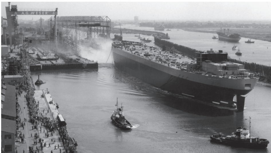
Abb. 3 Stapellauf TT ESO MERCIA. Das Bild, entstanden während des Umbaus der Hellinganlagen, zeigt deutlich den Unterschied in der Technologie des Schiffbaus, der für die Großtanker notwendig wurde. Rechts die nach dem Krieg wieder aufgebaute Helling 5 mit dem Krangerüst, unter dem mit zahlreichen kleineren Kränen ebenso zahlreiche kleinere Bauteile zu einem Schiff gefügt werden konnten. Dem stand links der Bockkran über dem neuen Helgen Wilhelm gegenüber, der zur Bewegung großer, vorgefertigter Bauteile diente. ESO MERCIA wurde im Oktober 1984 in Kaohsiung abgebrochen. (Foto: HAK/Archiv DSM)
