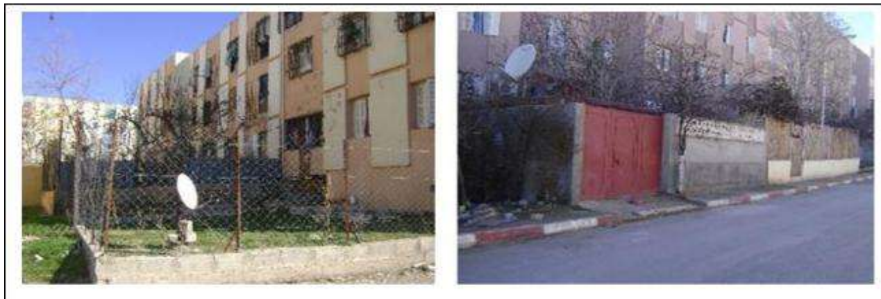
Figures 7 et 8. Une parabole et des clôtures privées en dur dans des espaces extérieurs
