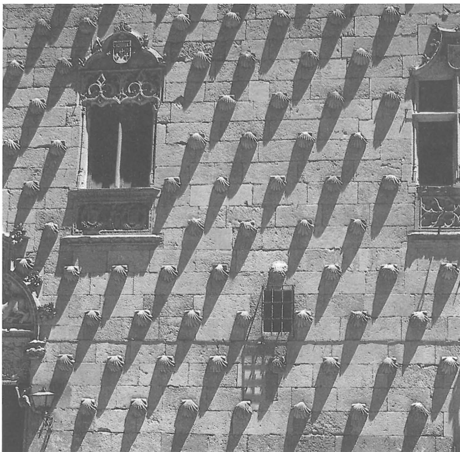
Abb. 9 Muscheldekoration an der Hauptfassade der Casa de las Conchas zu Salamanca, 1512–14.
