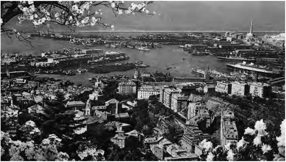
Abb. 14a Teilpanorama von Genuas Hafen mit Molo Nuovo und dem Rund des Porto Vecchio, daran – vor dem Ponte dei Mille auftauchend – die 100 m lange Front des 1911 entstandenen Kornsilos am Ponte Parodi, rechts davon liegt am Ponte Andrea Doria Italiens einziger Transatlantikliner mit »Blauem Band«, die REX. Ihre Position akzentuiert die »Lanterna«; italienische Foto-Postkarte von 1940; DSM. (Stiftung 2000)
