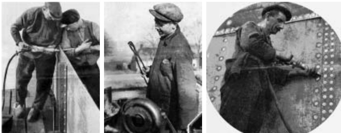
Abb. 5-7 Moderner Schiffbau bei Gebr. van Diepen im Jahr 1933 (von links): Nieter und Gegenhalter, Nietenschnitzer mit Feldschmiede, pneumatisches Stemmen.
