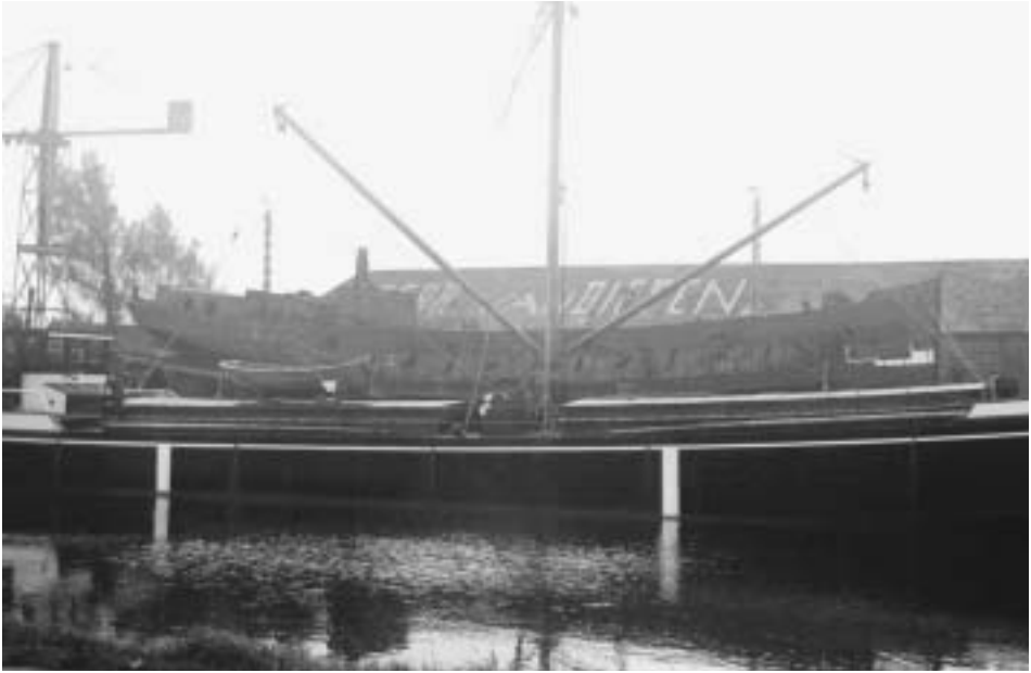
Abb. 4 Bau eines der rund 20 Schwesterschiffe der JUTLAND im Sommer 1930, hier das Binnenschiff STADT MARIENBURG, vor der Werft liegend.
