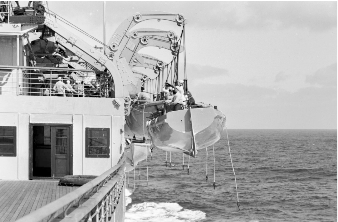
Abb. 4-8 Die BREMEN erhält einen Tarnanstrich. Die Bordwände wurden von den abgefeuerten Rettungsbooten aus umgestrichen. (Fotos: Hanns Tschira/Archiv DSM, Neg. 51455, 51494, 51477, 51449, 51434)
