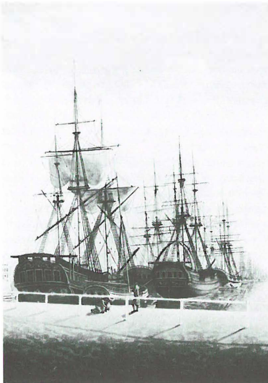
Abb. 6 »A West View of the New Dock at Kingston upon Hull.« Aquatintdarstellung von Robert Thew und F. Jukes, 1786/87 nach einem um 1780 entstandenen Gemälde. Anhand der Dwarsbalken über dem Achterdeck sind auf der linken Seite zwei Walfangschiffe identifizierbar. Das rechte von ihnen läßt in der Takelage des Kreuzmastes die spitzbogige Konstruktion von aufgerichteten Walkinnladen erkennen. (Kendall Whaling Museum, Sharon, Mass.)
