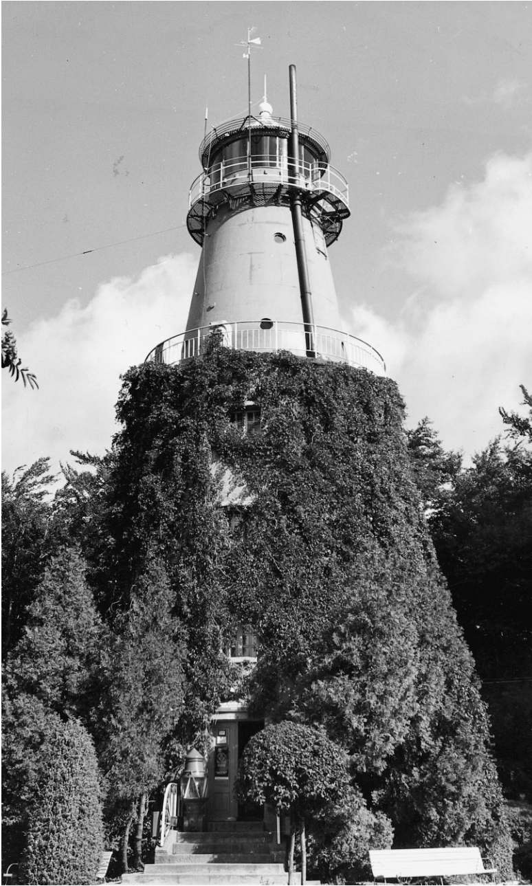
Abb. 15 1910 hat man den ersten Leuchtturm in Rixhöft (Rozewie) mit einem Stahlgußkegel um 5 m erhöht. (Foto um 1970 aus der Slg. des Verf.)
