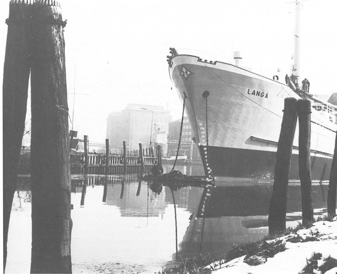
Abb. 18 Bei der Baunummer 1109 MS LANGA werden die Anker montiert, 1964
