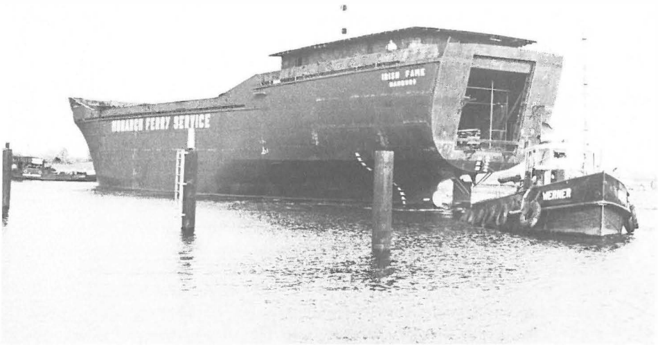
Abb. 19 Der Ro Ro Frachter IRISH FAME (Baunummer 1129) wird im Glückstädter Außenhafen zum Ausrüstungskai verbolt. Aufnahme 1971
