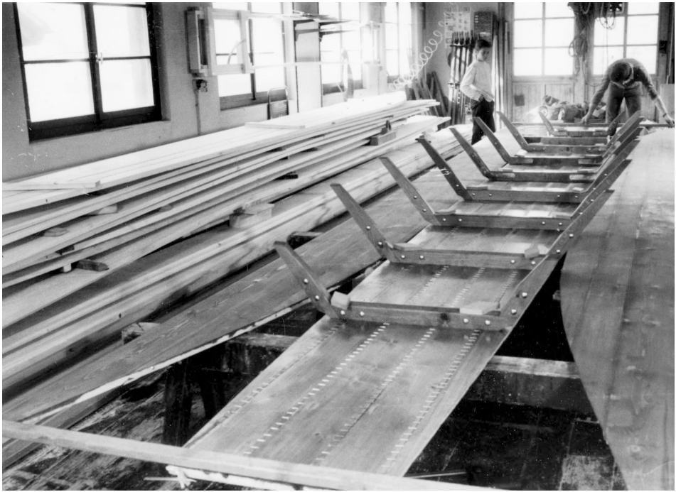
Abb. 10 Die mit Leiste und Klammern, den sog. Agraffen, abgedeckten Fugen zwischen den Bodenplatten eines Weidlings in der Werkstatt des Weidlingbauers Hans Waldmeier in Mumpf wecken die Vorstellung, dass das Boot »genäht« worden ist. (Foto: Roemari Spycher-Gautschi/Archiv DSM)
