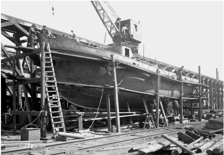
Abb. 7 C-24 auf dem Bauhelgen, kurz vor der Fertigstellung. 1938 baute die FSG insgesamt vier solcher »C-Schiffe« für die Kriegsmarine. (Foto: Archiv Flensburger Schiffahrtsmuseum)
