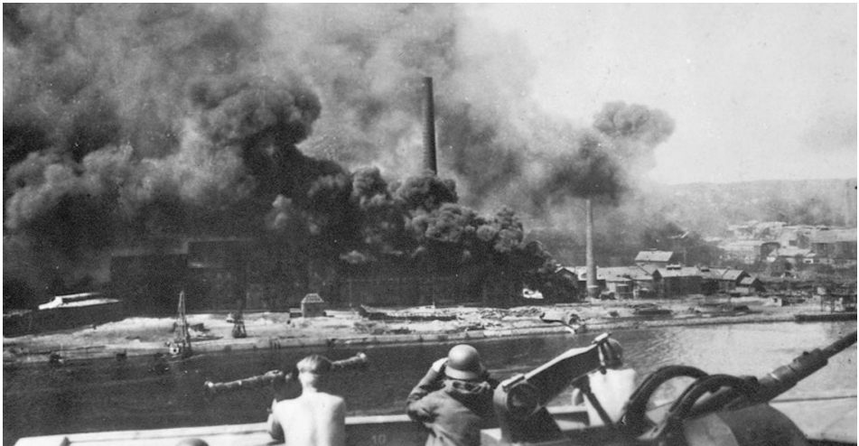
Abb. 17 Blick auf das Gelände der »Alten Werft« und die Zerstörungen durch den Angriff vom September 1942. Im Vordergrund ist das Holzlager zu erkennen, im Hintergrund sieht man die alte Tischlerei und den großen Dreibein-Kran. (Foto: Flensburger Stadtarchiv)
